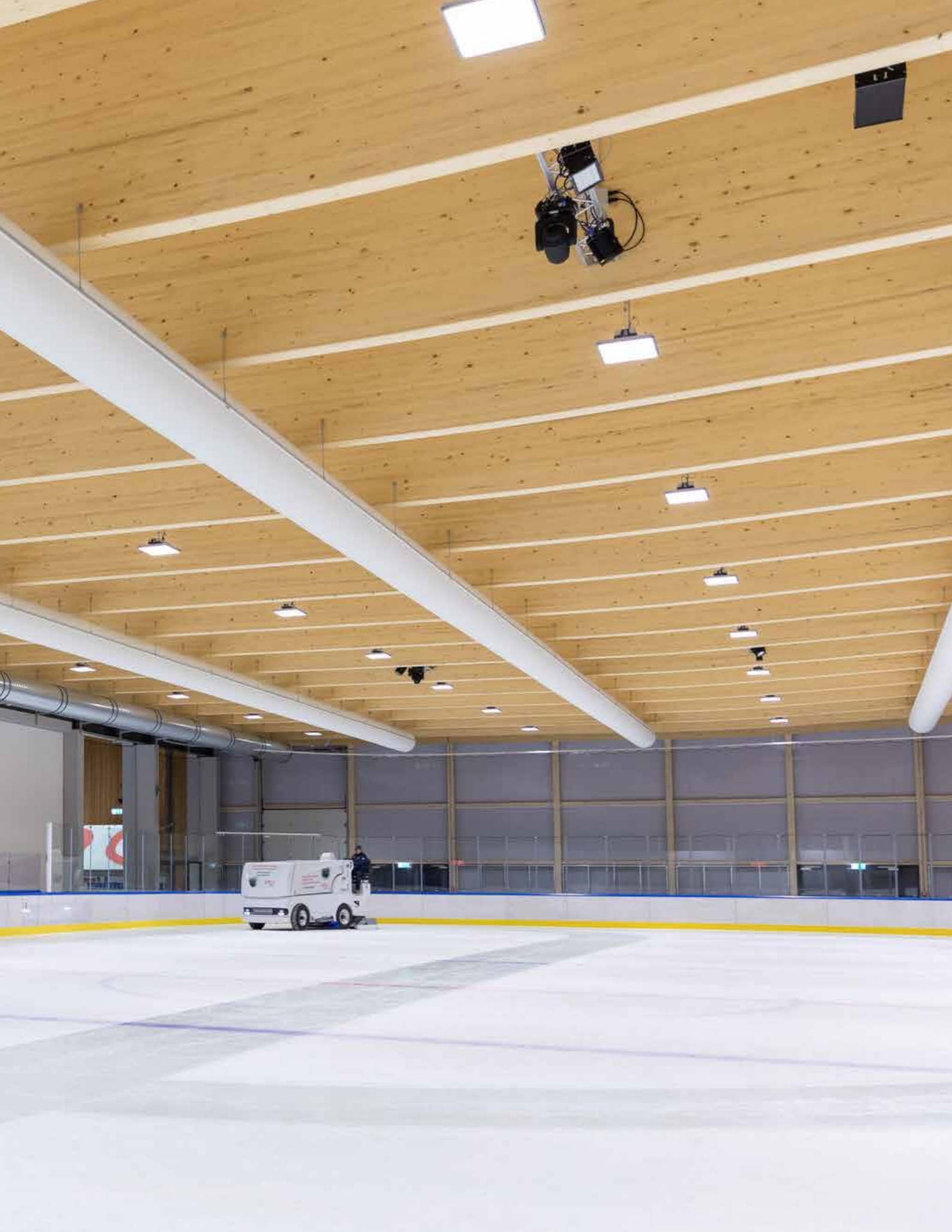
Ice arena Villingen-Schwenningen, Holzbau Amann GmbH
